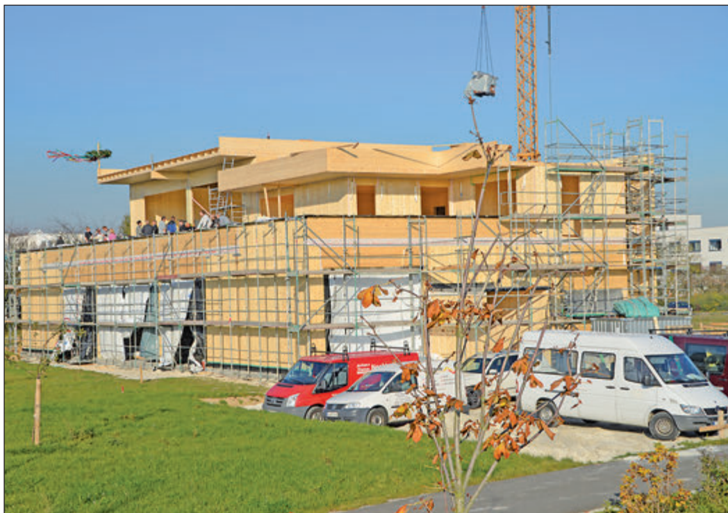
Außergewöhnlich als Sitz der Tanzschule Taktgefühl sowie der Medianisement Studios ist das Holzhaus am Sportpark, in dem sich gut feiern lässt, wie die Party unterm Richtkranz bewies.
